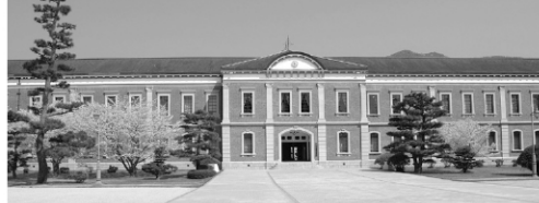
江田島海上自衛隊幹部候補生学校庁舎。通称「赤レンガ」1893（明治26）年に建設された。（提供：海上自衛隊）
