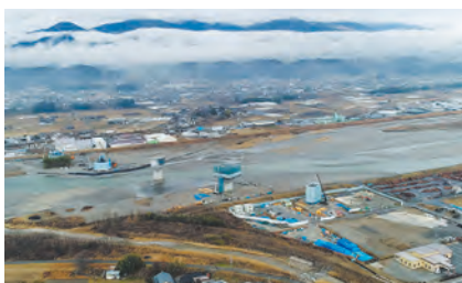
リニアの天竜川橋りょう工事(橋木村から)
