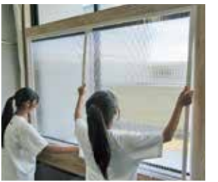
内窓の設置(断熱ワークショップ)
